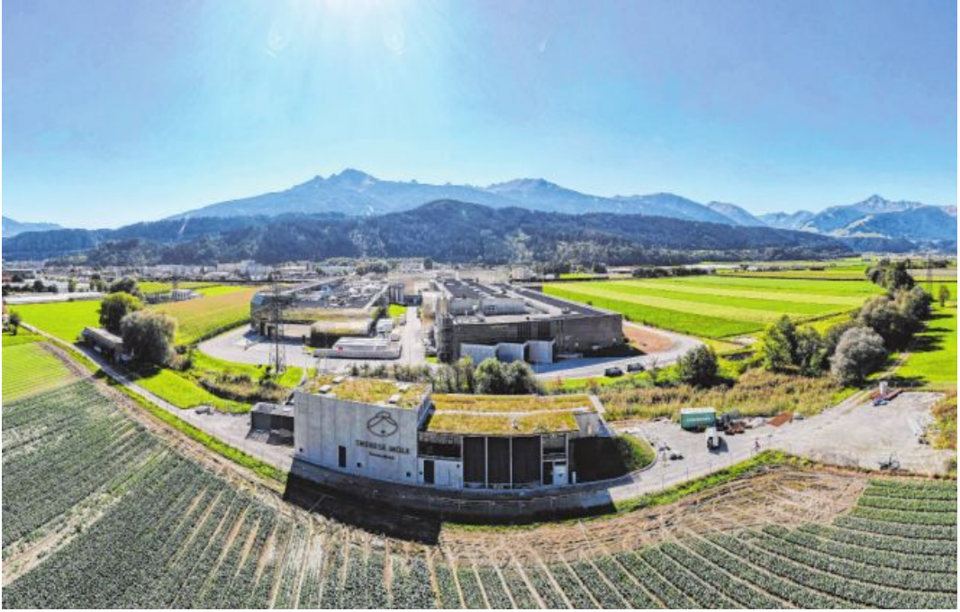
In der MPreis-Zentrale in Völs ist seit Frühling 2022 eine firmeneigene Produktionsanlage für grünen Wasserstoff in Betrieb. Dieser wird zur Beheizung der Backöfen der firmeneigenen Bäckerei eingesetzt. Foto: MPreis/Franz Oss
